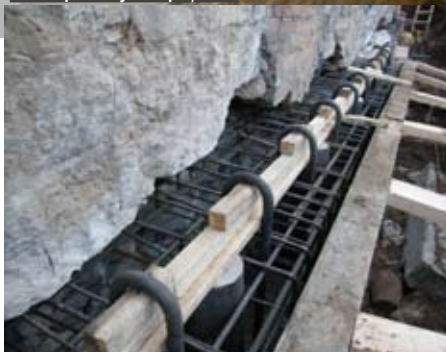
Pa pils perimetru un arī zem nesošajā sienām tika veikta pamatu stiprināšana ar iespiestajiem pāļiem.
